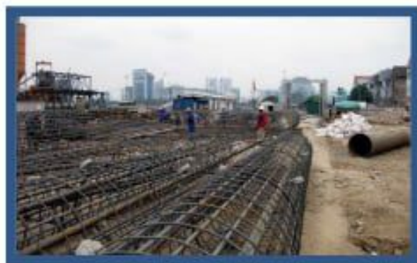
ỨNG DỤNG LÀM CỌC SIÊU ÂM ULTRA SOUND PILE APPLICATION
